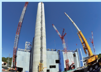
工事が進む高浜クリーンセンター
